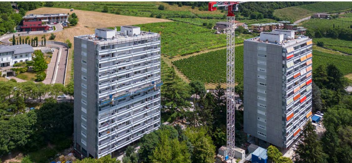
“L’intervento, effettuato mediante l’utilizzo di pannelli a secco di facciata per la riqualificazione dell’involucro, ha permesso di realizzare questi lavori con la presenza degli abitanti all’interno dell’edificio in modo rapido e con un cantiere dove la tecnologia off-site ha aiutato a garantire elevati standard di qualità e velocità di assemblaggio.”
